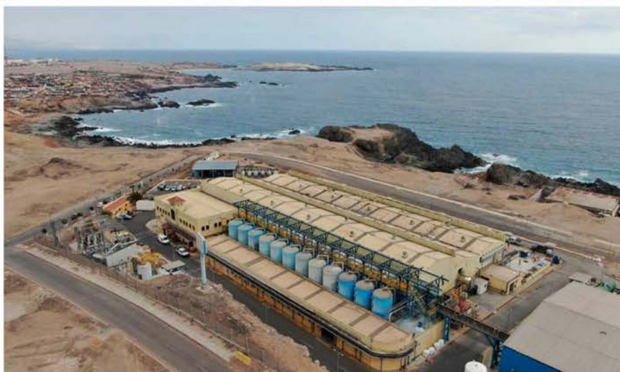
Planta desaladora de Antofagasta | Foto: Prensa Aguas Antofagasta
